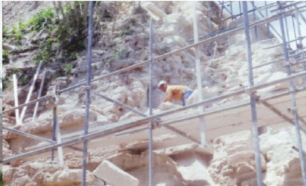
Edificio 5C-49, Fialko, 1981, (Figura 12B)
